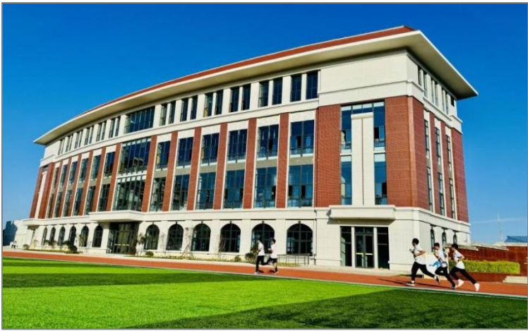
图 1-8 学校新建综合实训楼
